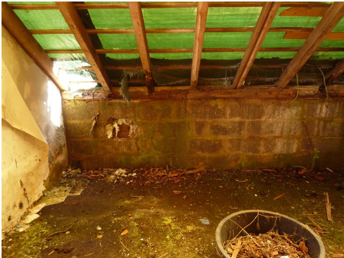
Foto 3 Dachgeschoss des Gebäudes mit Foliendach
