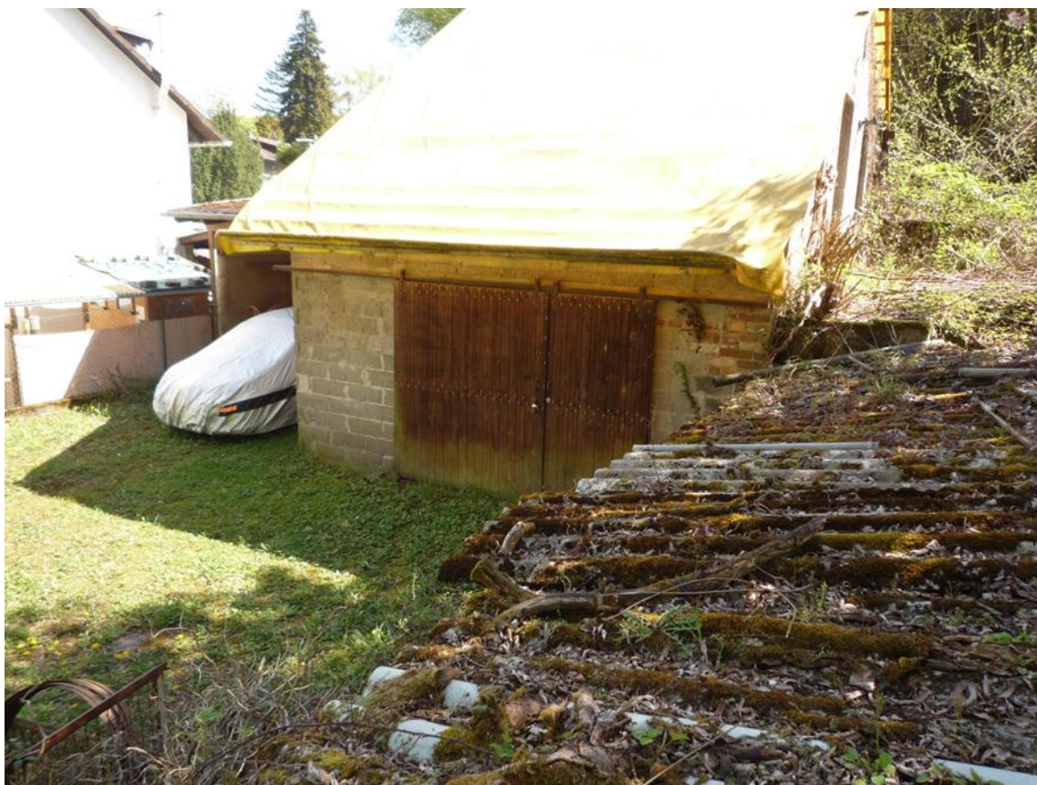
Foto 1 Geplantes Baugrundstück mit Schuppen und Carport
